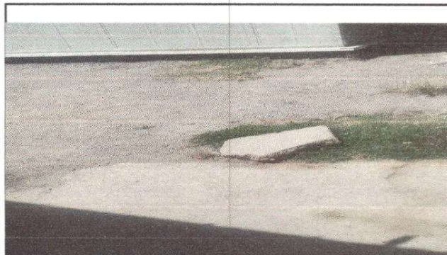
Foto 4: Reparación de planchas de concreto de patio.
