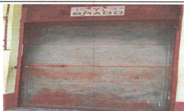
Foto 2: Mantenimiento a estructura (Lijado, cambio de tubo, cepillado, sujeciones, aplicación de pintura)
