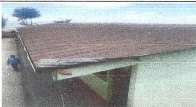
Foto 1: Sustrucción de lámina, por lámina troquelada.
