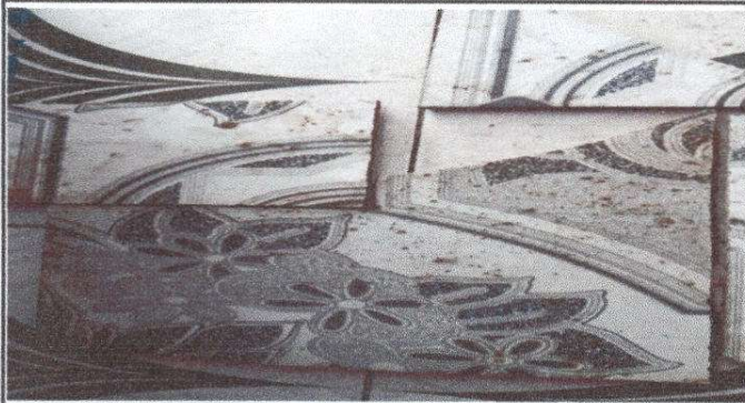
Foto7: Sustitución de piso cerámico.
